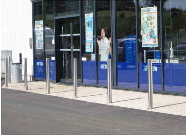
Matérialisation des cheminements piétons
