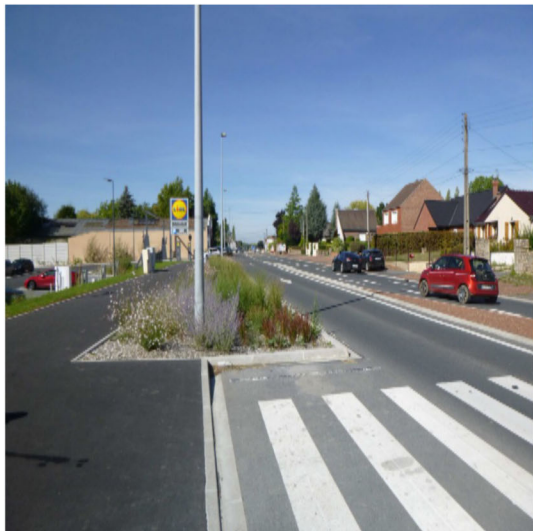
Réalisation d'un parterre
