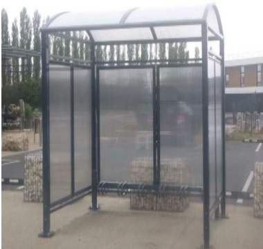
Abris vélo réalisé
