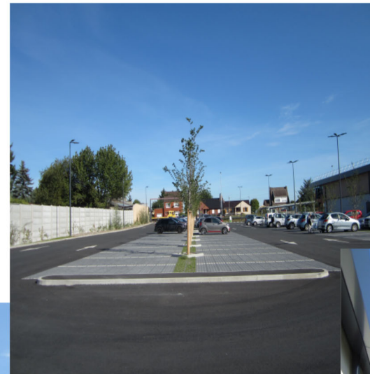
Parking perméable et planté
